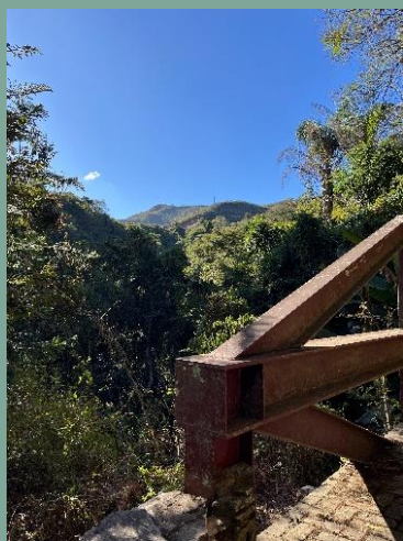
Ponto 4– Trecho sob a Ponte Xavier.
