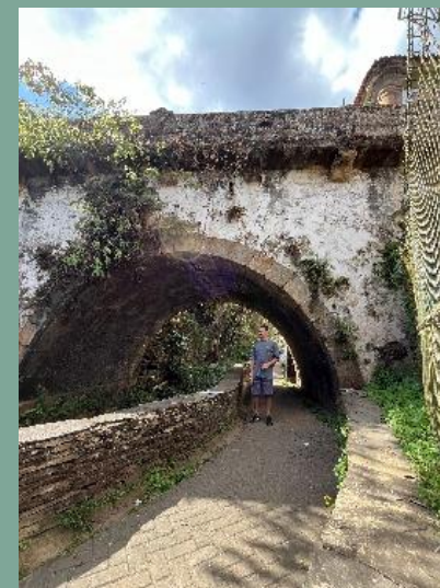
Ponto 3 Via principal sob a Ponte dos Contos.
